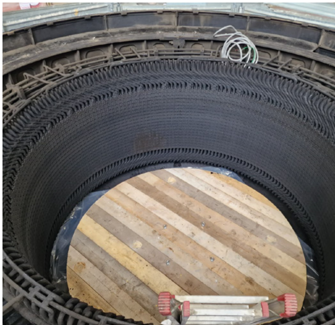
ABB spa, Manutenzione generatori elettrici
