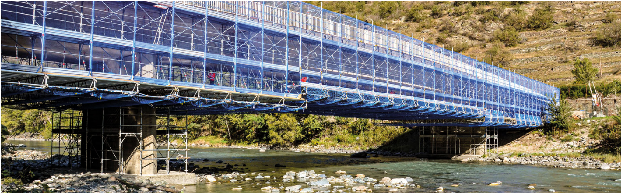
Cantiere SR 15, Brissogne (AO)
