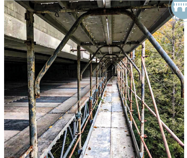
Viadotto Bumaz, S.S. 27 Km 11+618 (AO)
