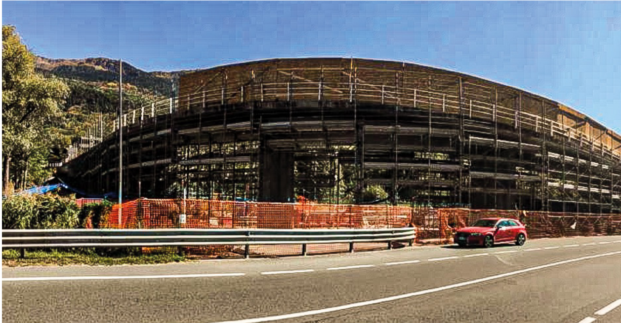
Cavalcavia Ferroviario, S.S. 54 Sarre (AO)
