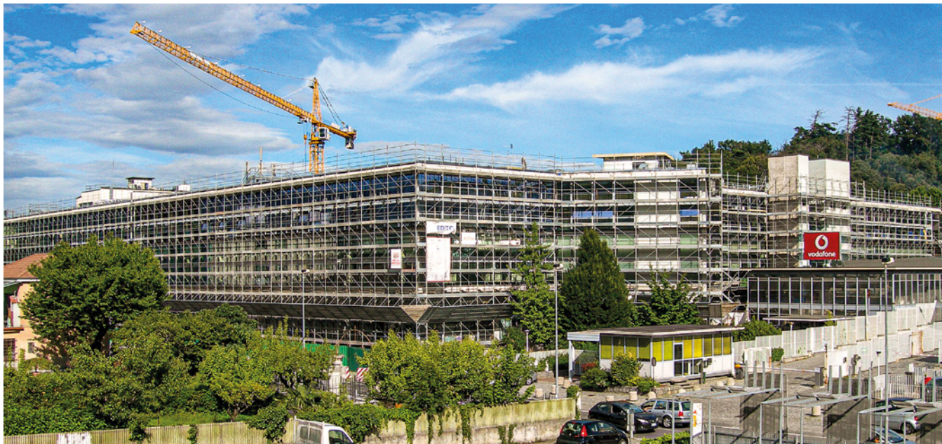
Ex sede Olivetti Nuovi Uffici Vodafone, Ivrea (TO)
