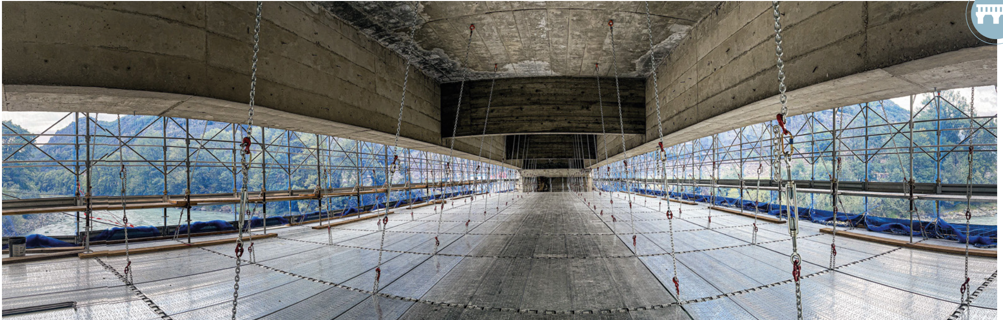
S.R.10, Pontey (AO)
