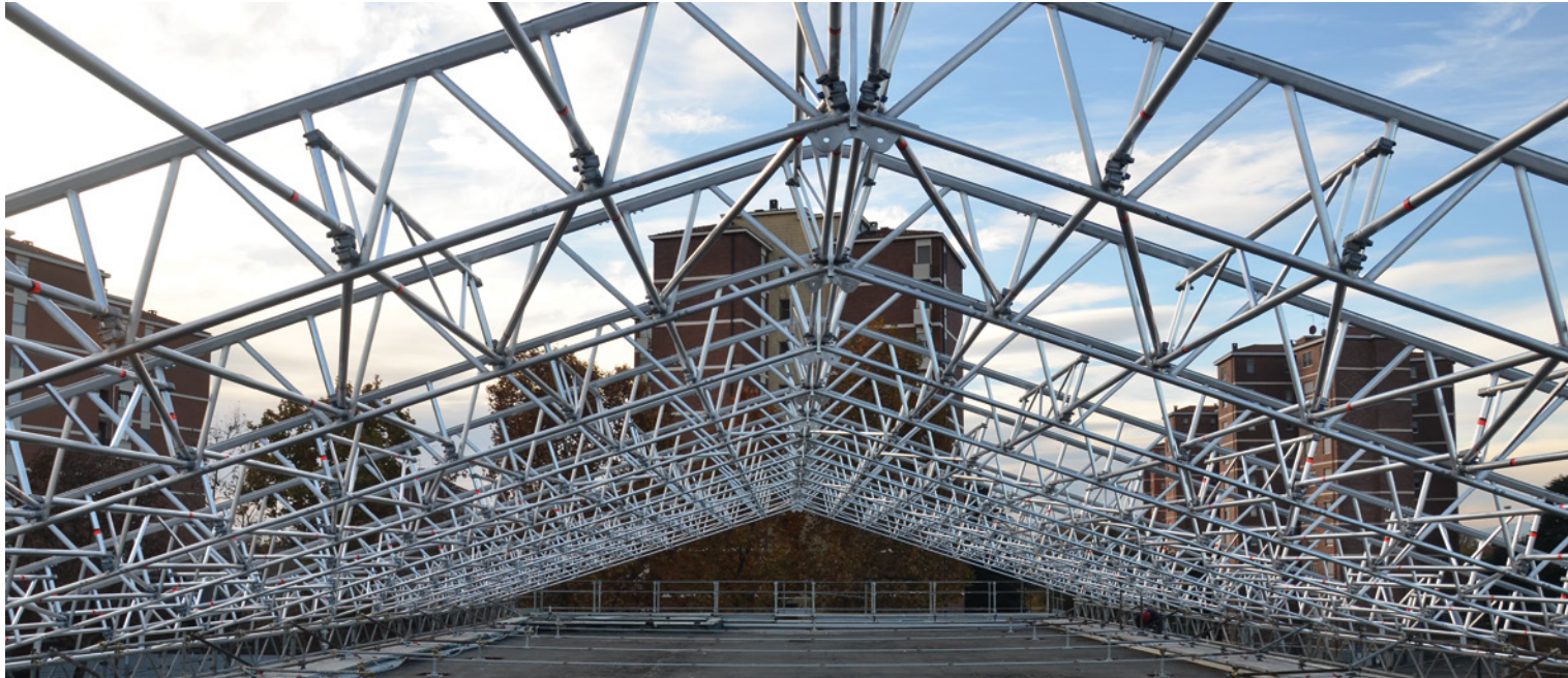
Copertura provvisoria Via Crispi, Varese
